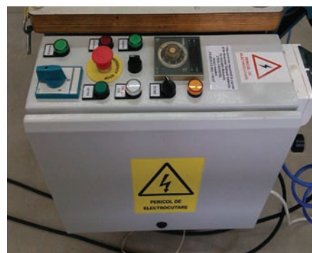
Fig. 54. Imagine de ansamblu a sistemului integrat in linia tehnologica de fabricatie a beneficiarului
